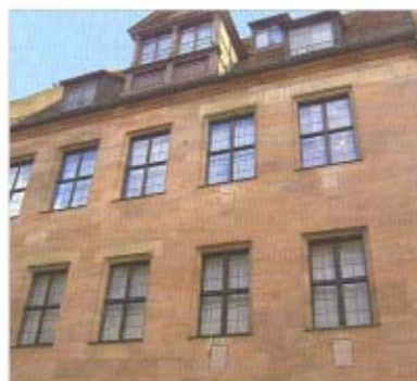
Das Rückgebäude des Fembohauses in Nürnberg wurde mit Histoglas-Isolierfenstern ausgestattet.
