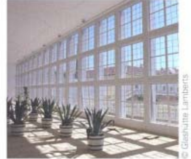
Wiederhergestellte Holz-Glas- Konstruktion der Orangerie auf Schloss Hof
