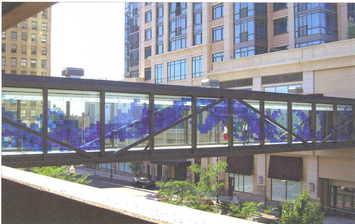
Projekt: Trump Tower Bridge, New Rochelle, New York: Mundgeblasene Echtantikgläser auf Isoliergläser vor Ort aufgeklebt. Artwork: Catharine Widgery (USA); Ausführung: Glas+Räume GmbH. Foto: Jörn Neumann
